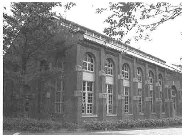
図1 熊本大学工学部研究資料館外観(重要文化財)
