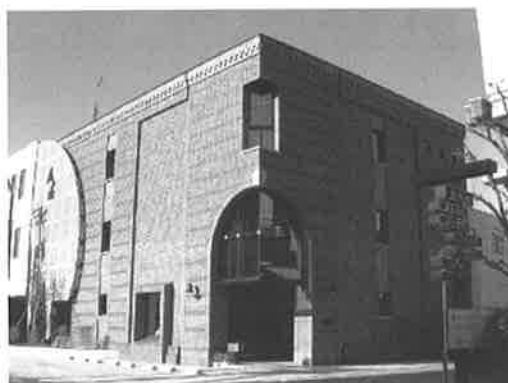
図1 大正ロマン風の外観
