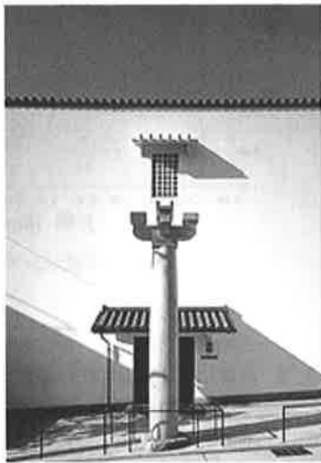
図1 竹中大工道具館 外観(正面)
